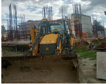
कोशी अस्पतालको नयाँ भवन निर्माण हुँदै गएको अचुरो भवन ।
