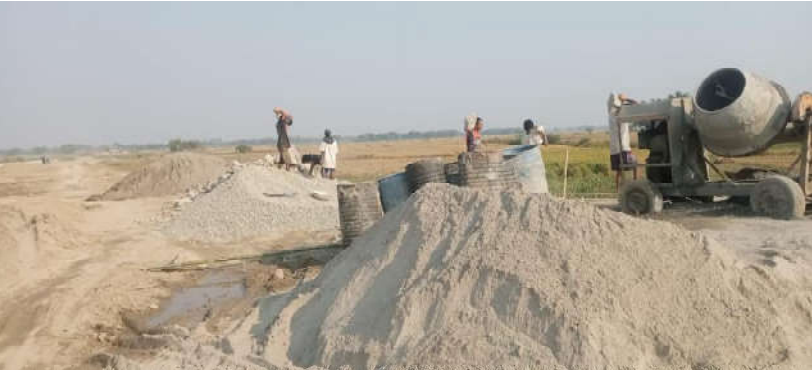
हुलाकी राजमार्गको रंगेली नगरपालिका देखि रतुवामाई नगरपालिकाको चौकी घाटको सडक खण्ड निर्माण हुँदै ।
