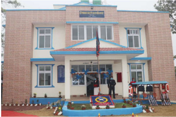
विराटनगर महानगर पालिका वडा नं. १४ रानीमा बनेको इलाका प्रहरी कार्यालयको नयाँ भवन ।
